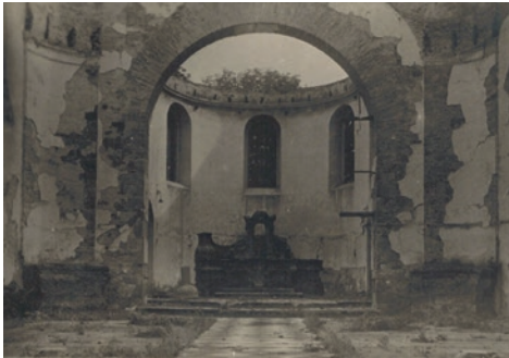
Nach der Zerstörung: Kirchenschiff und Chor
