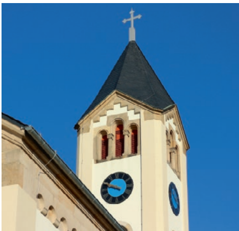
Kirchturm: Rheinischer Helm und Drillingsfenster
